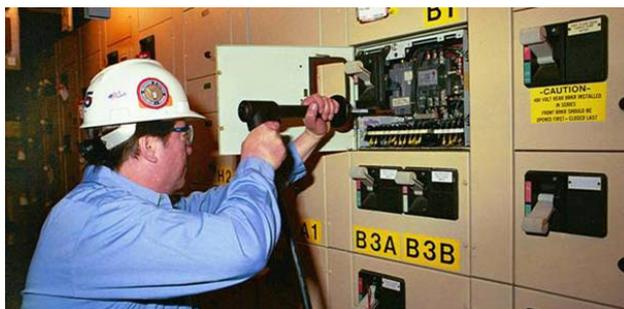
Test de disjoncteur moulé avec le HCP2000
